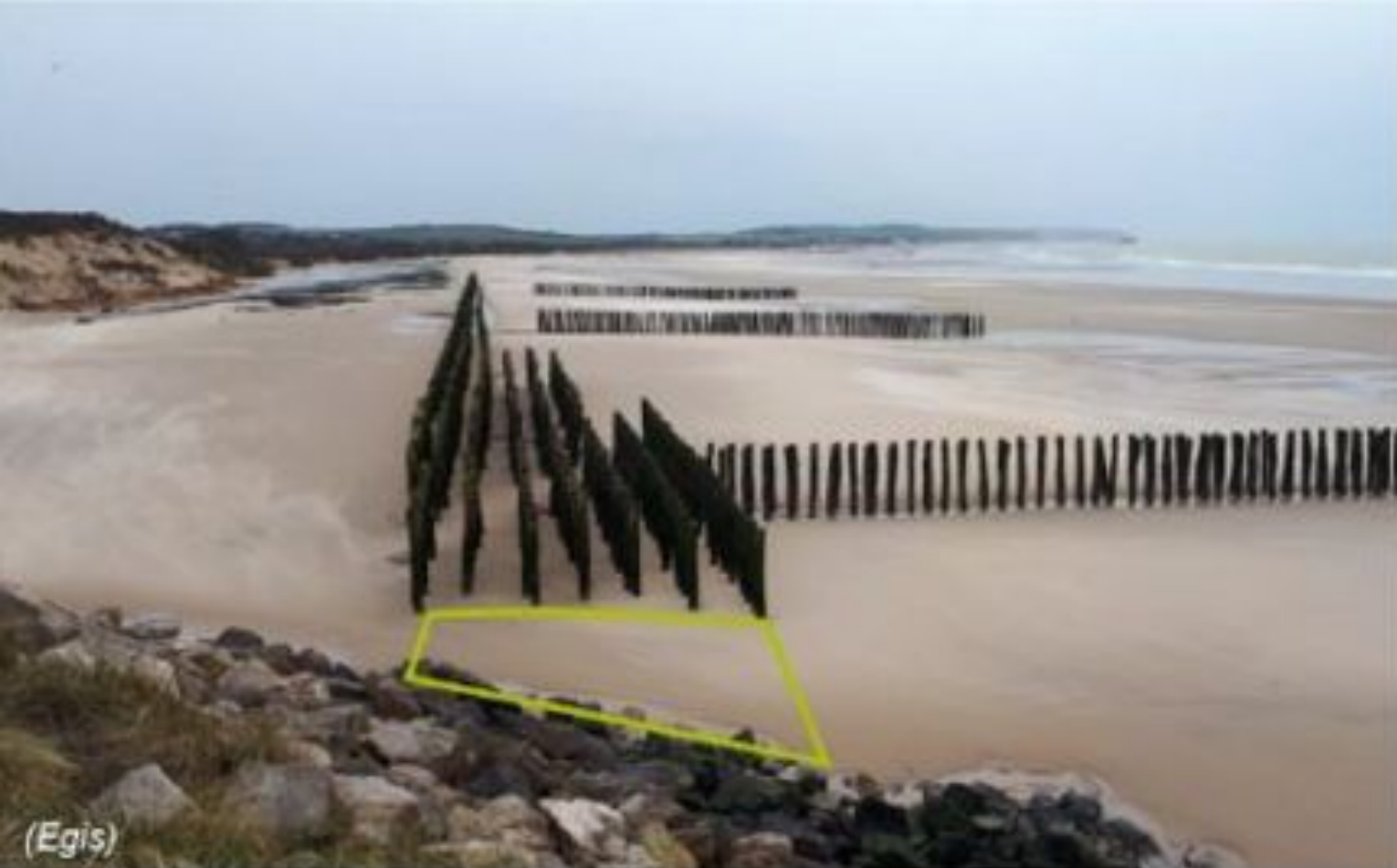
Figure 52 : Gauche : Transit éolien sur l'estran, fuyant à la jonction des pieux bois et du perré (en vert la zone à aménager) ; Droite : sable éolien capté par les débris de la laisse de mer
