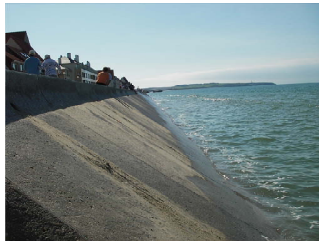
Perré (vers le sud-ouest)
