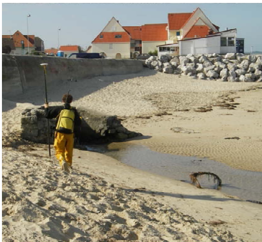
Exutoire proche poste de secours
