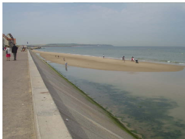
Perré (vers le sud-ouest)
