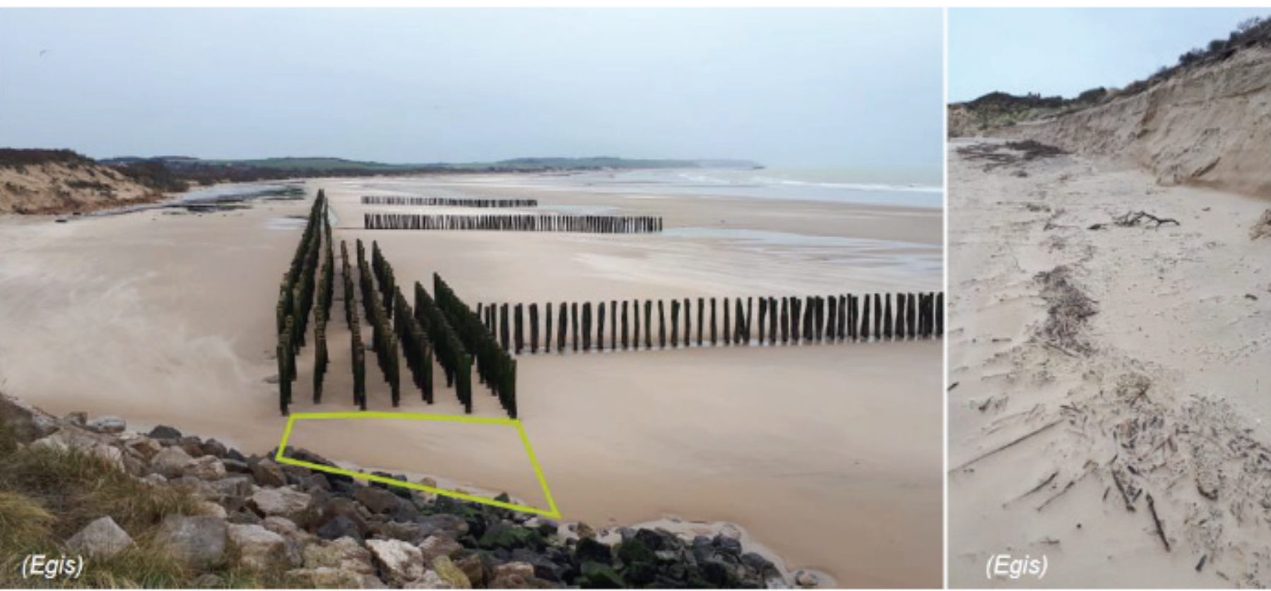
Figure 52 : Gauche : Transit éolien sur l'estran, fuyant à la jonction des pieux bois et du perré (en vert la zone à aménager) ; Droite : sable éolien capté par les débris de la laisse de mer
