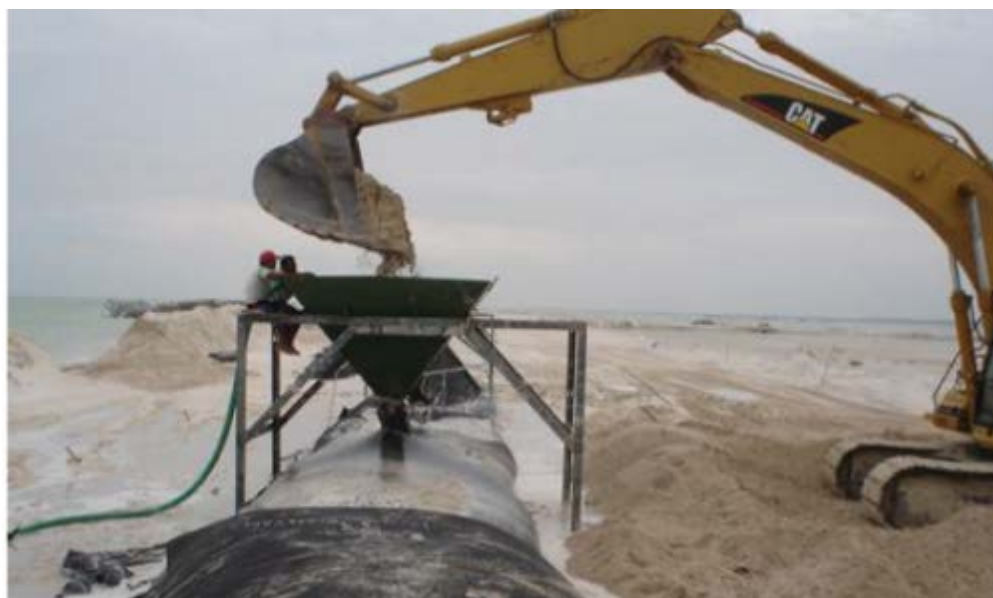
Figure 21 - remplissage d'un tube en géotextile
