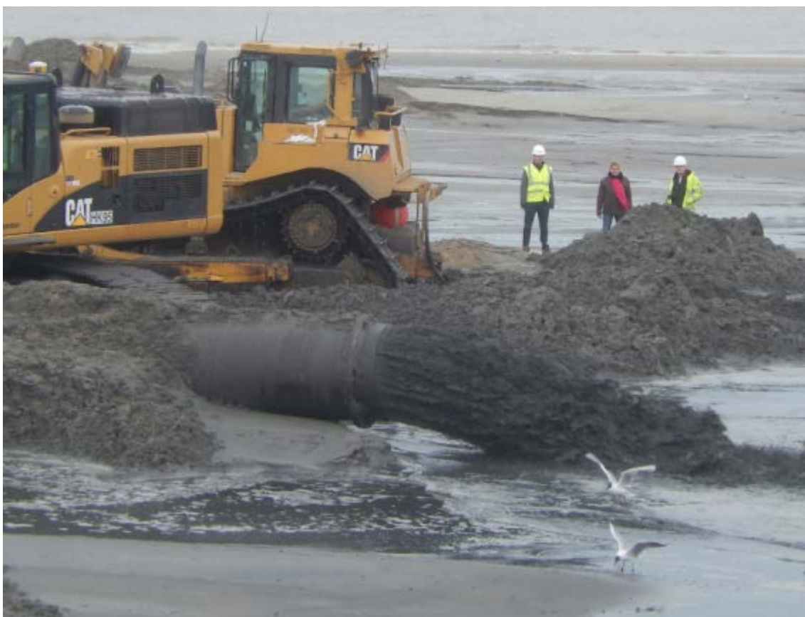
Photo 18 - Refoulement de la mixture sable/eau sur la plage (EGIS, rechargement de la Digue des Alliés, 03/2014)
