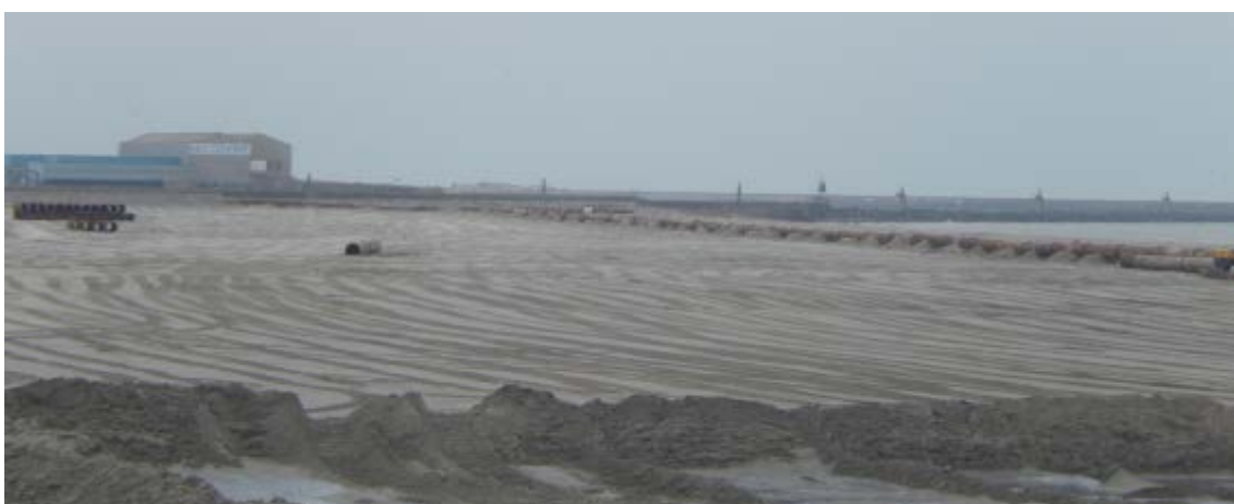
Photo 20 - Profil de plage après rechargement (EGIS, rechargement de la Digue des Alliés, 03/2014)
