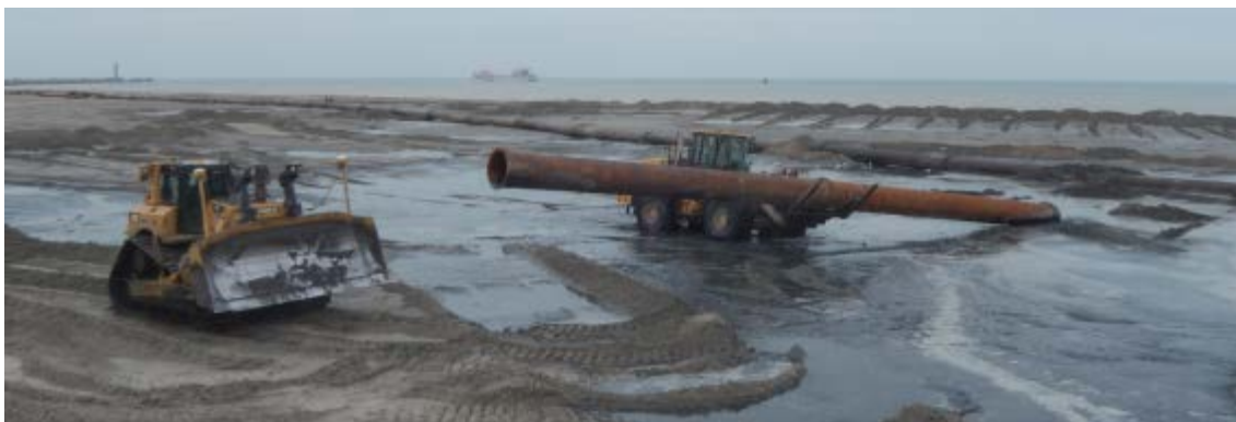
Photo 17 - Préparation de la conduite à terre (EGIS, rechargement de la Digue des Alliés, 03/2014)
