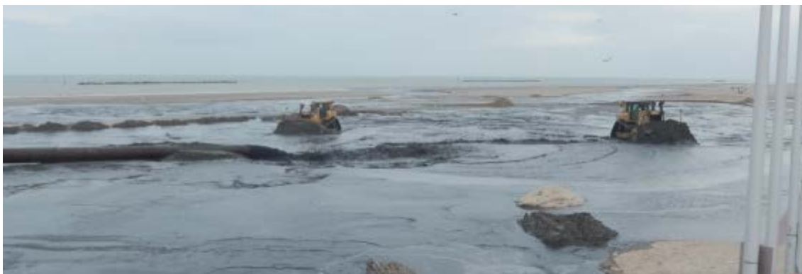
Photo 19 - Régalage du sable et reprofilage de la plage (EGIS, rechargement de la Digue des Alliés, 03/2014)
