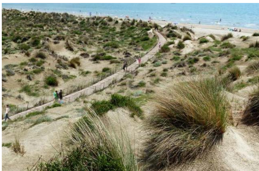
Figure 10 : Exemple d'accès aménagé à l'aide d'un platelage composé de lattes de bois.
